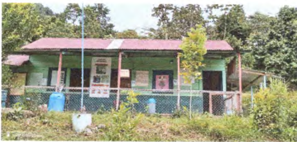
Foto 5: cambio de laminas con goteras
